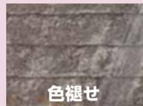
風雨、紫外線などにより、塗膜の表面が劣化して起こる現象
