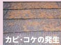
屋根表面が劣化し、雨水が染み込むことで発生する現象
